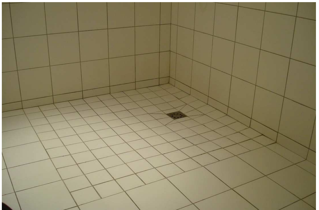
afb. 16.4 - 20 Goede afloop met weinig snijwerk.
