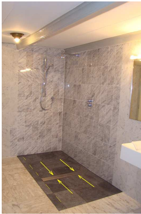
afb. 16.4 - 21 Afschot van twee kanten
