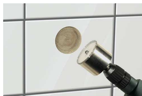
afb. 16.4 - 5b Gatendoor met pilootboor
