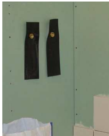
afb. 16.4 - 14 Strookjes kimband rond de wateraansluitingen. Deze worden dan met afdichtpasta op de gipskartonplaten vastgezet, dan een laag dichtpasta erover heen.
