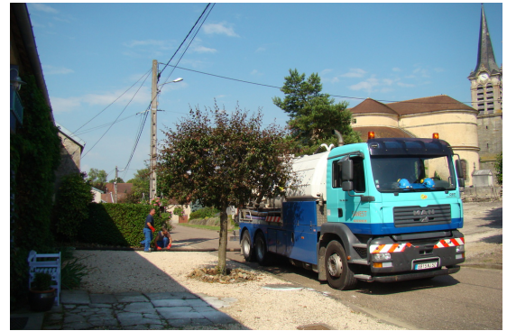
afb. 11 - 6 De tankzuiger staat voor het huis, de afzuigleiding wordt gelegd
