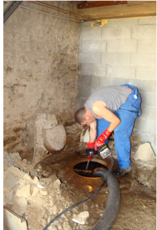
afb. 11 - 7 De fosse wordt leeggezogen
