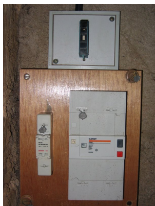
13.1.2 - 1 Veel voorkomende disjoncteur de branchement; hiernaast, afb.2, zijn moderne broertje
