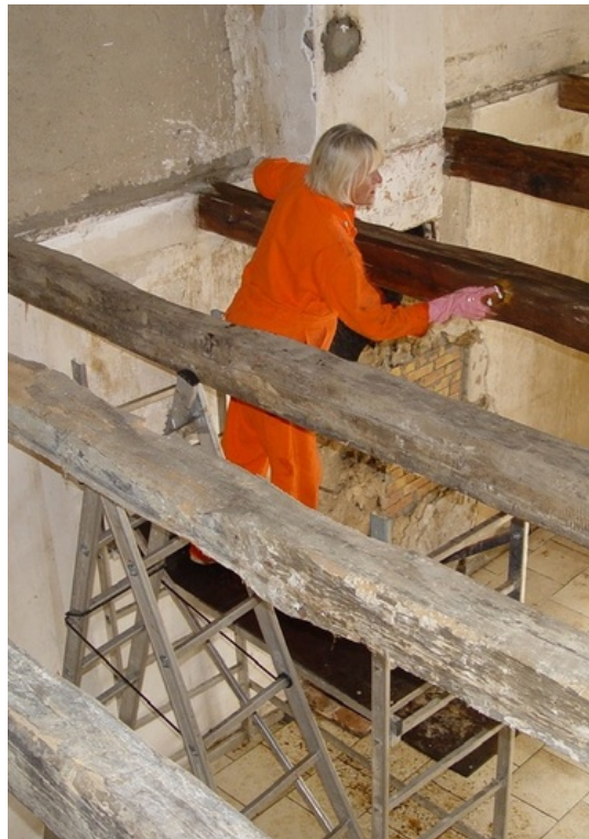
afb. 20.3 - 8 Steiger met één verdieping, goede werkhoogte voor binnen
