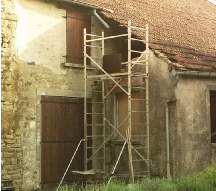
afb. 20.3 - 9 Buiten met opgezette tweede verdieping. Het luik is opengeklapt, want u beklimt de steiger steeds aan de binnenkant, nooit buiten! Of gebruik een ladder naast de steiger zoals op afbeelding 8.
