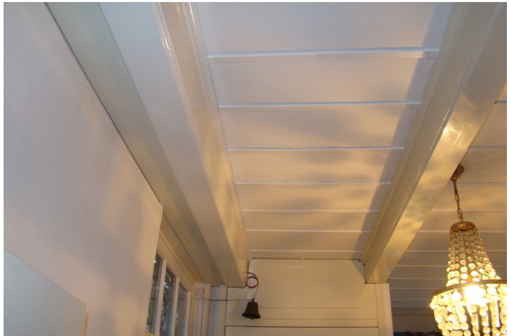
afb. 10.2.2 - 7 Rioleringsbuis weggewerkt met planken die een nepbalk vormen -> This is how I covered an 80mm shower drain by a false beam
