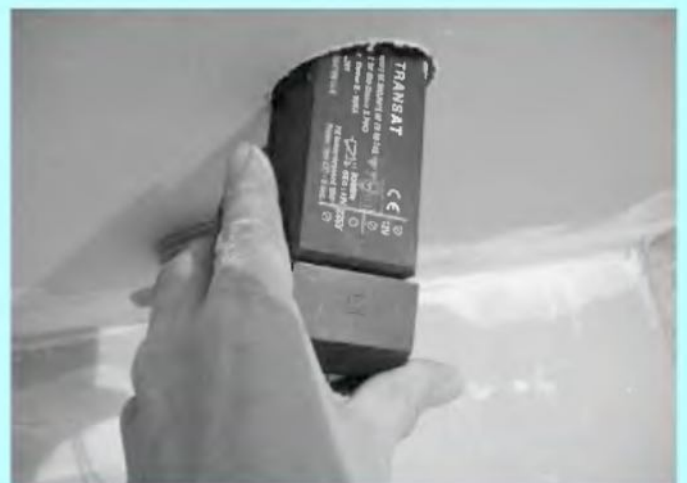
6 - Introduisez le transformateur dans le faux plafond.
