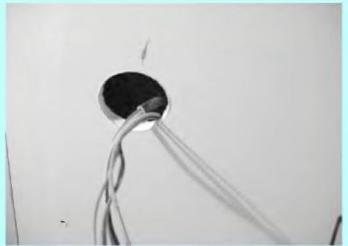
2 - Percez le faux plafond et récupérez les câbles.
