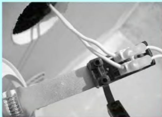
8 - Raccordez l'alimentation du spot.
