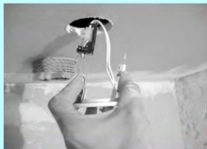
10 - Montez le spot dans le faux plafond.
